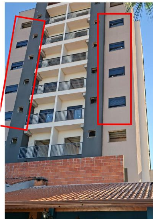
21/06/2026 - Janelas com vidros instalados
